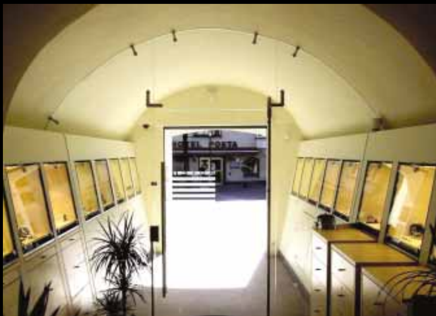
Glaselemente, punktgenau im Rundbogen, Ladeneingangsbereich, Klausen
